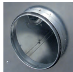
Juntas de estanqueidad en las bocas de aspiración.
