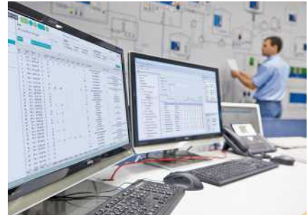
Telecontrol: transmisión segura y continua de datos de proceso a la sala de control
