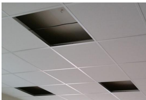
Montaje: empotrar o apoyar en perfiles de aluminio
