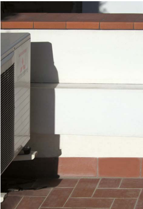
Rehabilitación de viviendas
