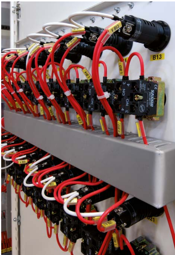
Túneles e infraestructuras ferroviarias
