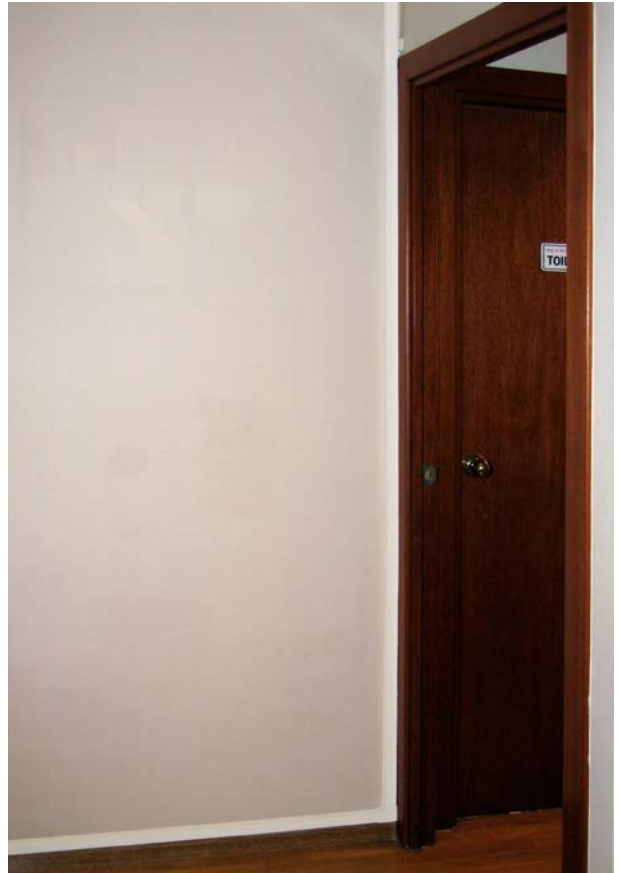
Rehabilitación de viviendas
