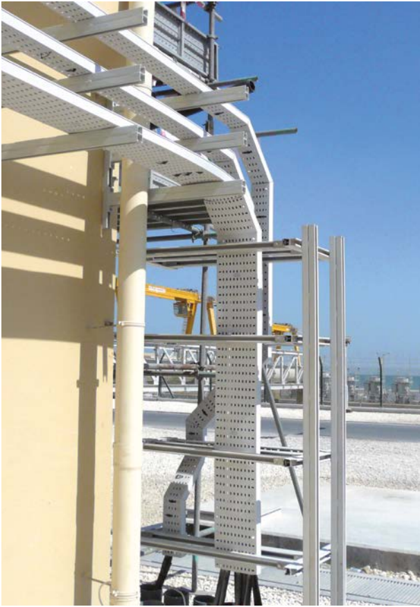
Tratamiento de aguas: desalinizadora
