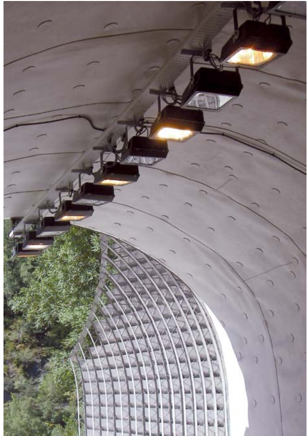
Infraestructura viaria: túnel
