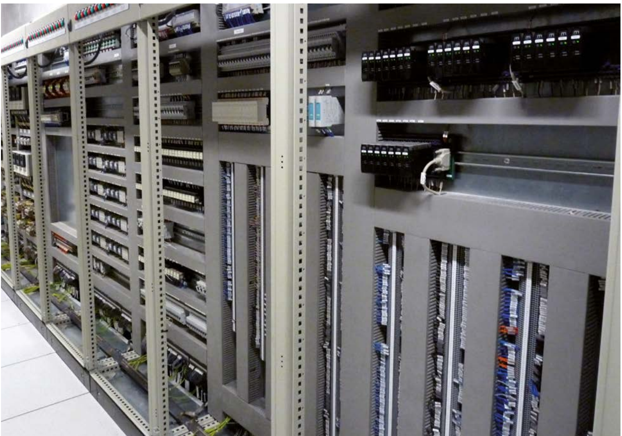
Tratamiento de aguas
