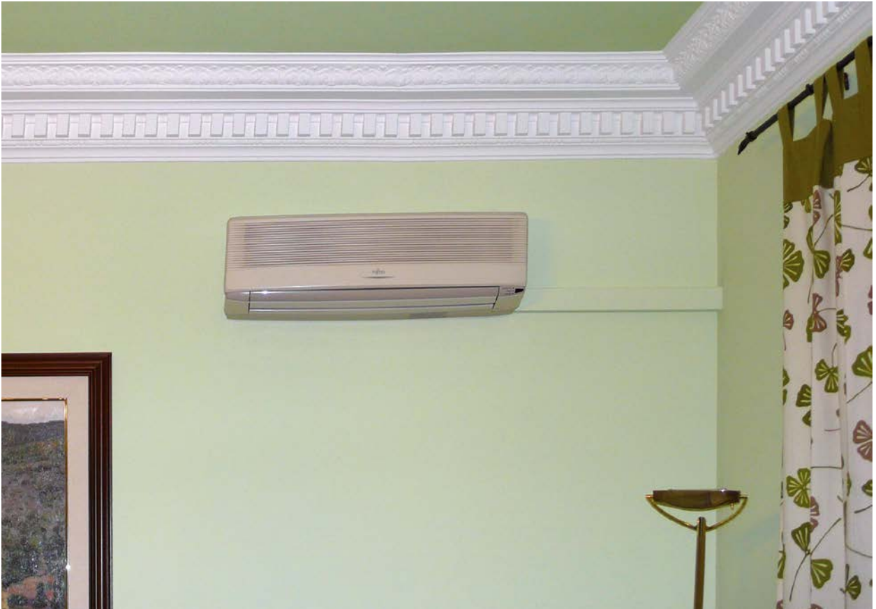
Rehabilitación de viviendas
