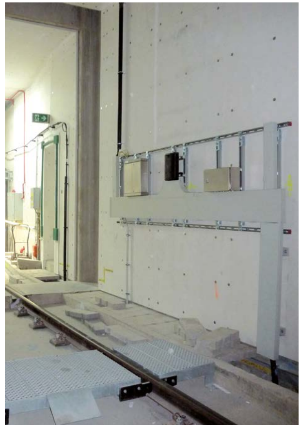
Infraestructura ferroviaria: túnel
