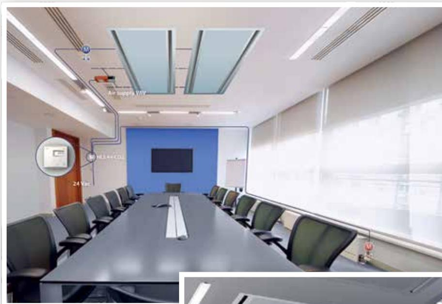
En la sala de conferencias, el HLS 44-CO2 (página 24) puede controlar vigas frías y un actuador para ventilación en caso de que los valores de CO<sub>2</sub> sean demasiado elevados o si se necesita activar el enfriamiento. La calefacción se controla mediante radiadores.
