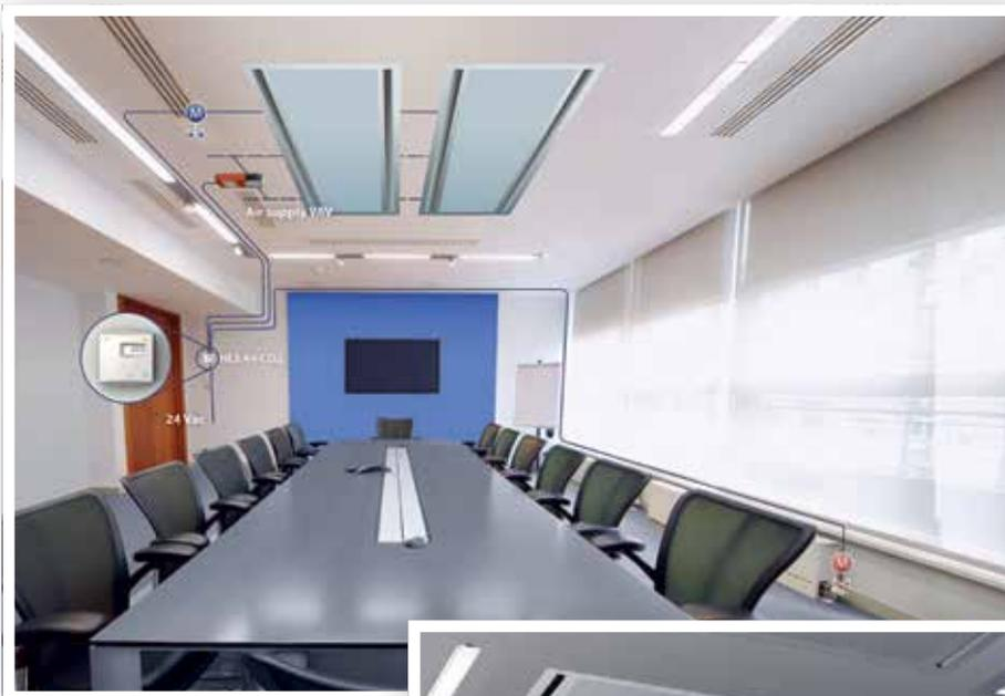
En las salas de conferencias, el HLS 44-CO2 (página 28) puede controlar las vigas frías con refrigeración y un actuador de compuerta para la ventilación si los valores de CO<sub>2</sub> son demasiado altos o si se necesita refrigeración. La calefacción se controla con radiadores.
