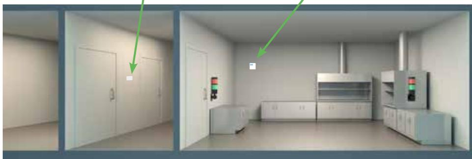
El DPT-CR-MOD mide la diferencia de presión entre la sala blanca y la antesala y envía la información al sistema de automatización a través de Modbus para mantener unas condiciones óptimas en la sala blanca. El DPT-CR-MOD se conecta al transmisor de calidad del aire interior Siro, que mide la humedad relativa y la temperatura. El Siro envía la información al DPT-CR-MOD, el cual la muestra en su pantalla junto con la medición de la presión diferencial.
