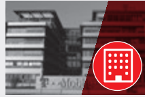
Terciario construcción Service & retail construction
