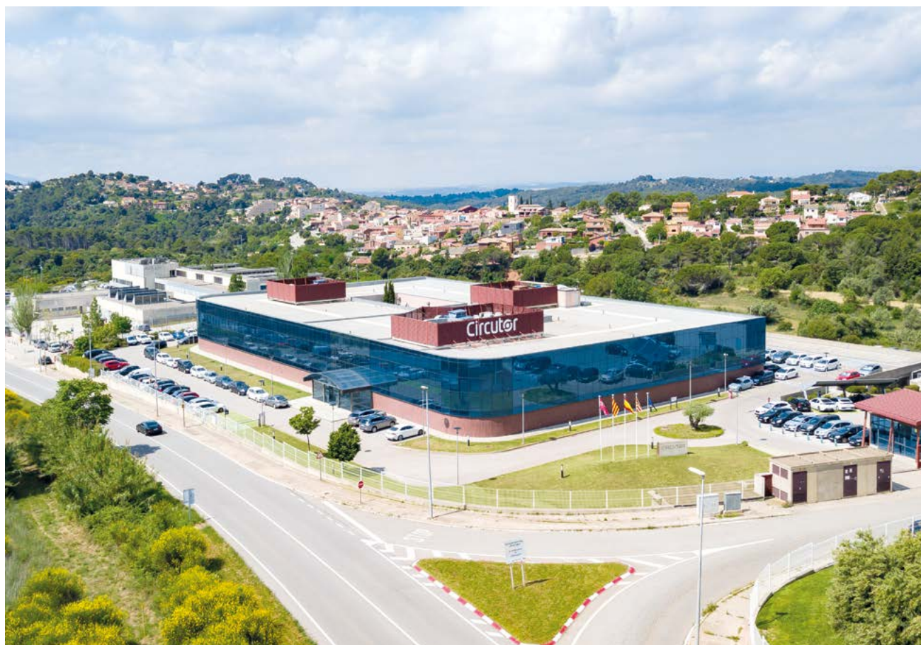
Sede central de CIRCUITOR en Viladecavalls, Barcelona.
