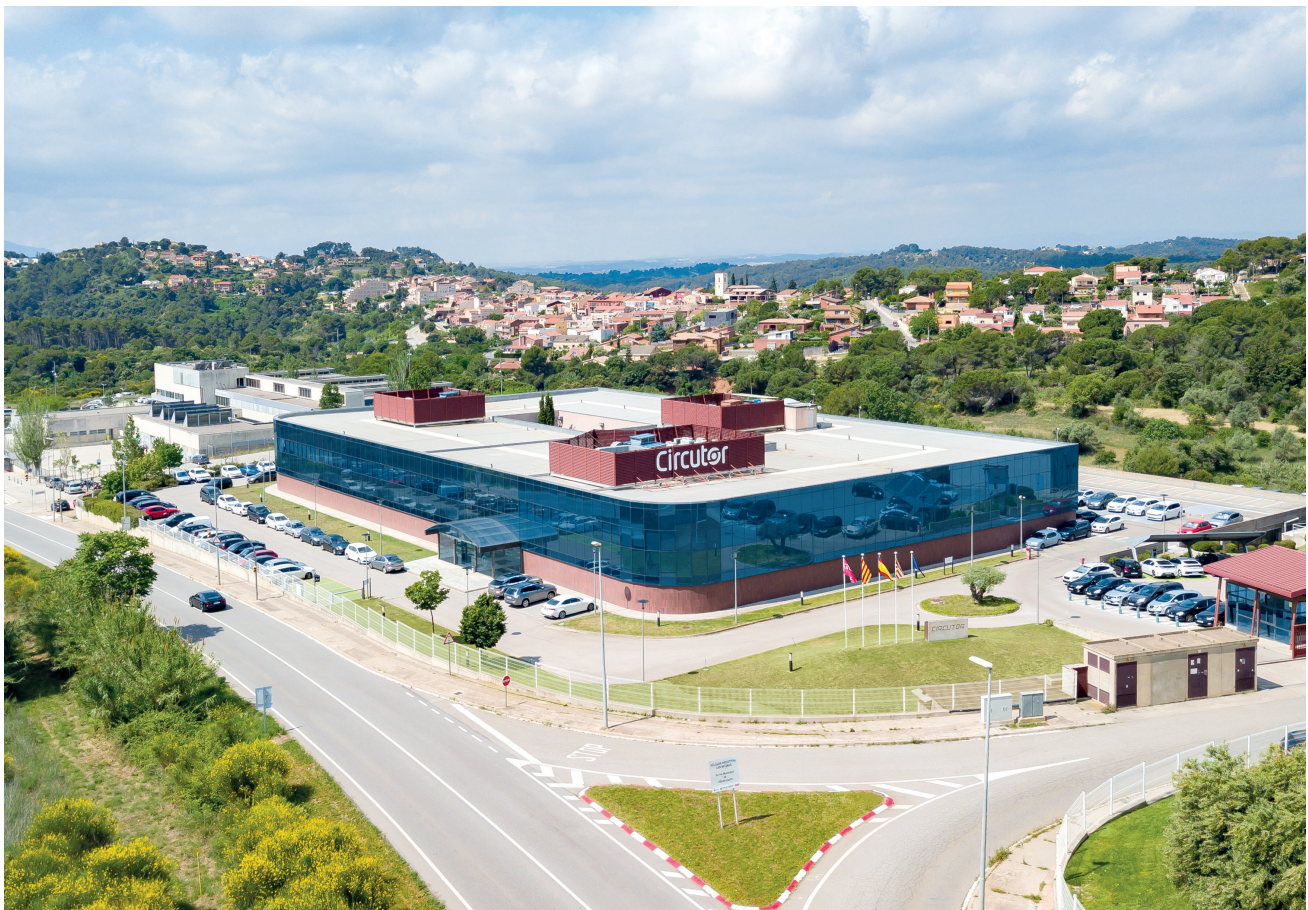
Sede central de CIRCUITOR en Viladecavalls, Barcelona.
