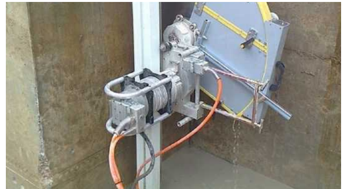
Betonsägemaschine / Concrete saw
